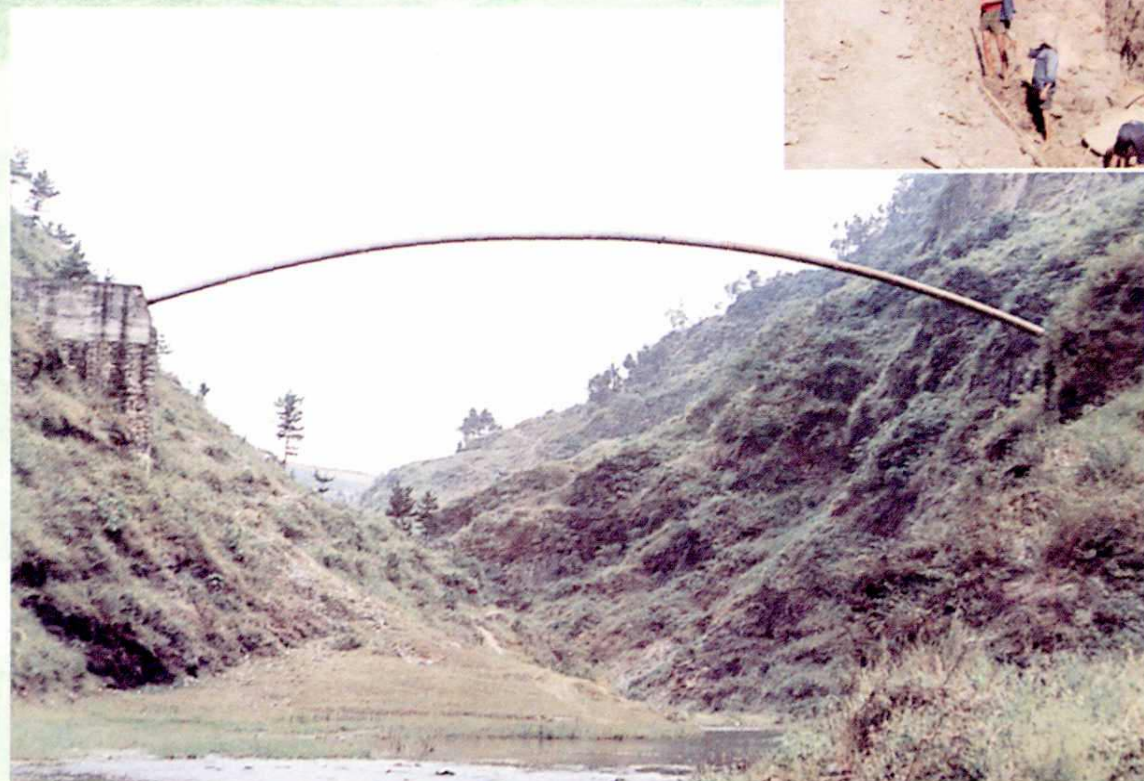
汉阴县观音峡拱形钢渡水管
