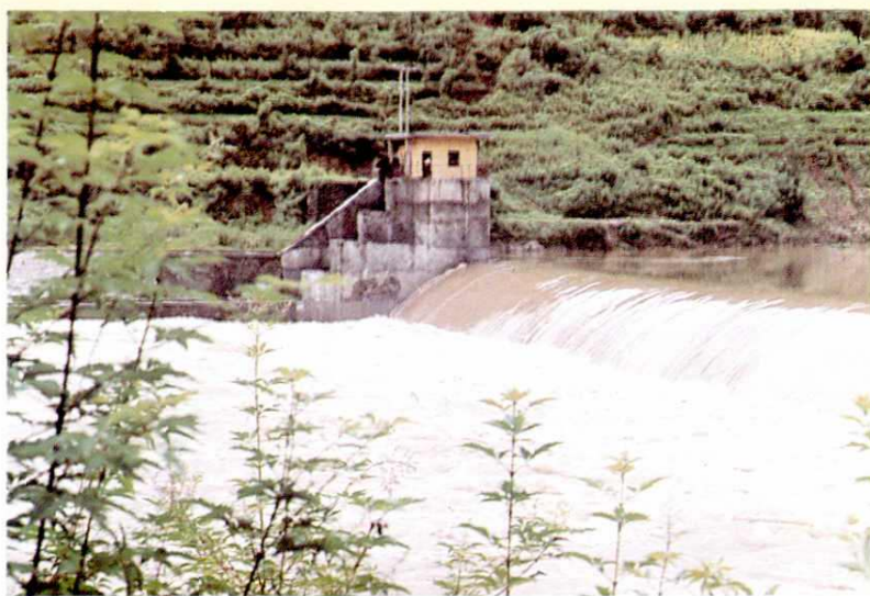
石泉县胡家湾电站滚水坝
