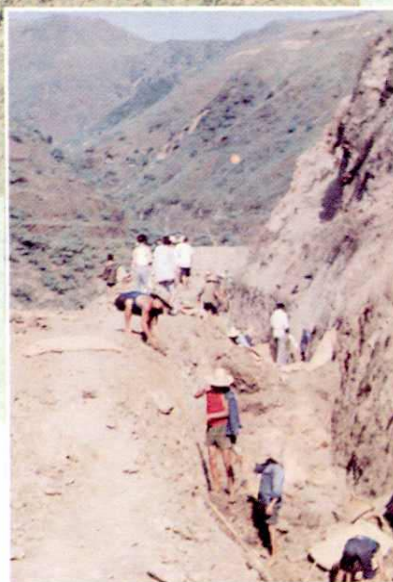
渠道工程施工现场
