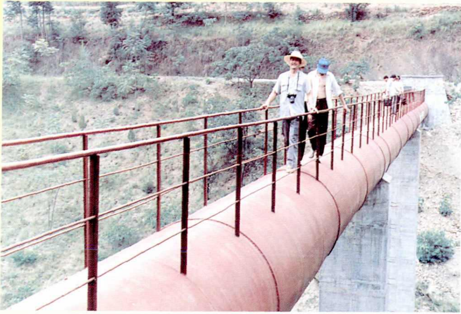
安康市八一水库东干渠大倒虹吸管
