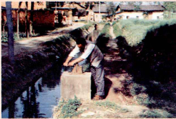
整修放水斗闸 做好灌溉管理
