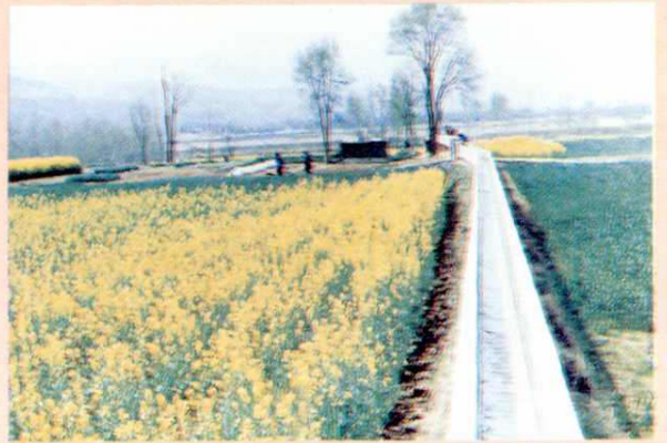
八一水库灌区U形渠道
