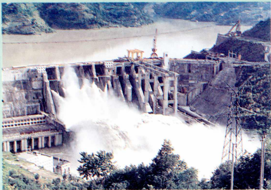
汉江梯级开发—安康火石岩水库电站
