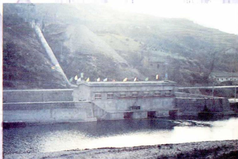
平利县古仙水电站全景
