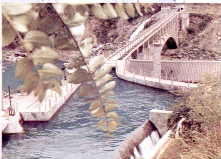
镇坪县南江河电站引水渡槽 地区水电设计院 供稿
