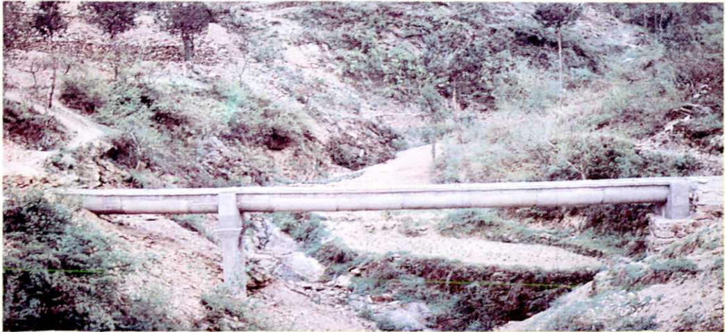
旬阳县西惠渠灌区薄壳渡槽
