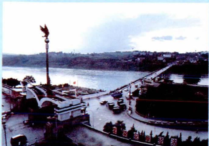
安康大桥防洪闸全景
