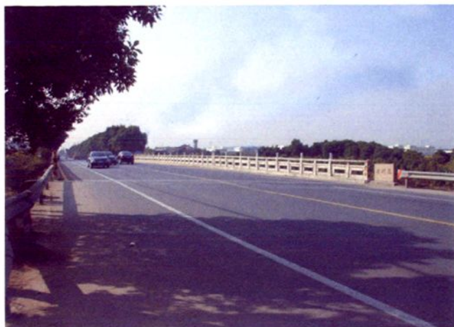
1989 年 5 月建造的钱胡路直湖港唐村大桥
