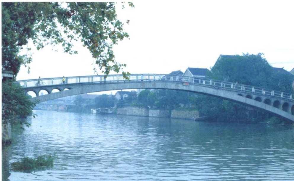
1965 年建造的全国首座跨度 55 米的双曲拱桥——胡埭直湖港大桥
