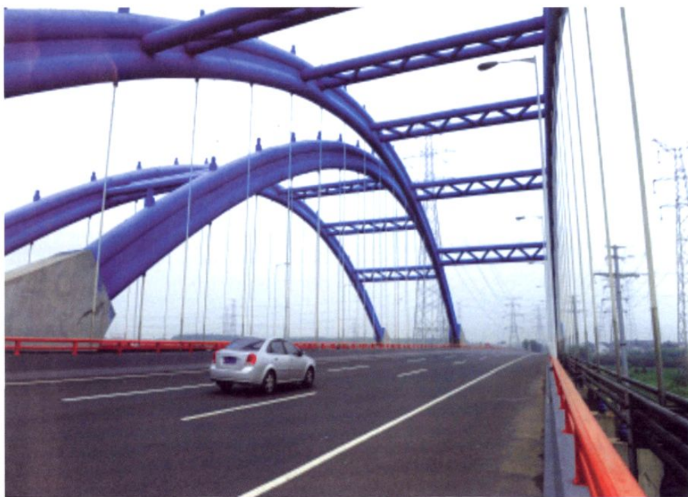
342 省道胡埭直湖港大桥
