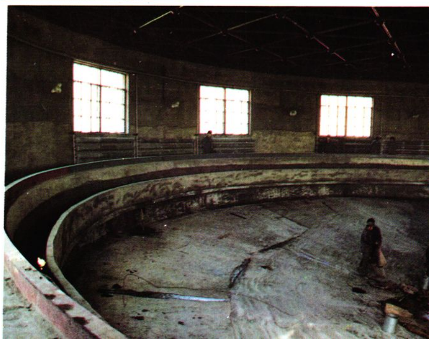
3 在建中的大明一矿选煤厂浓缩池
