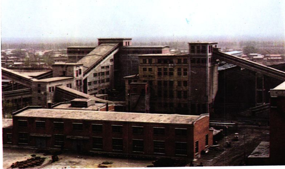
1 小青矿选煤厂外景
