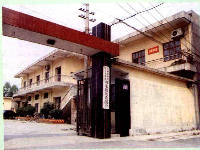
居委会办公大楼
