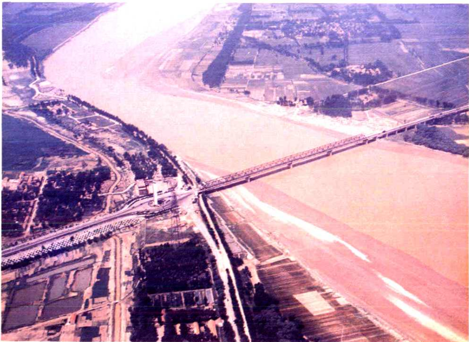
滨州黄河大桥
