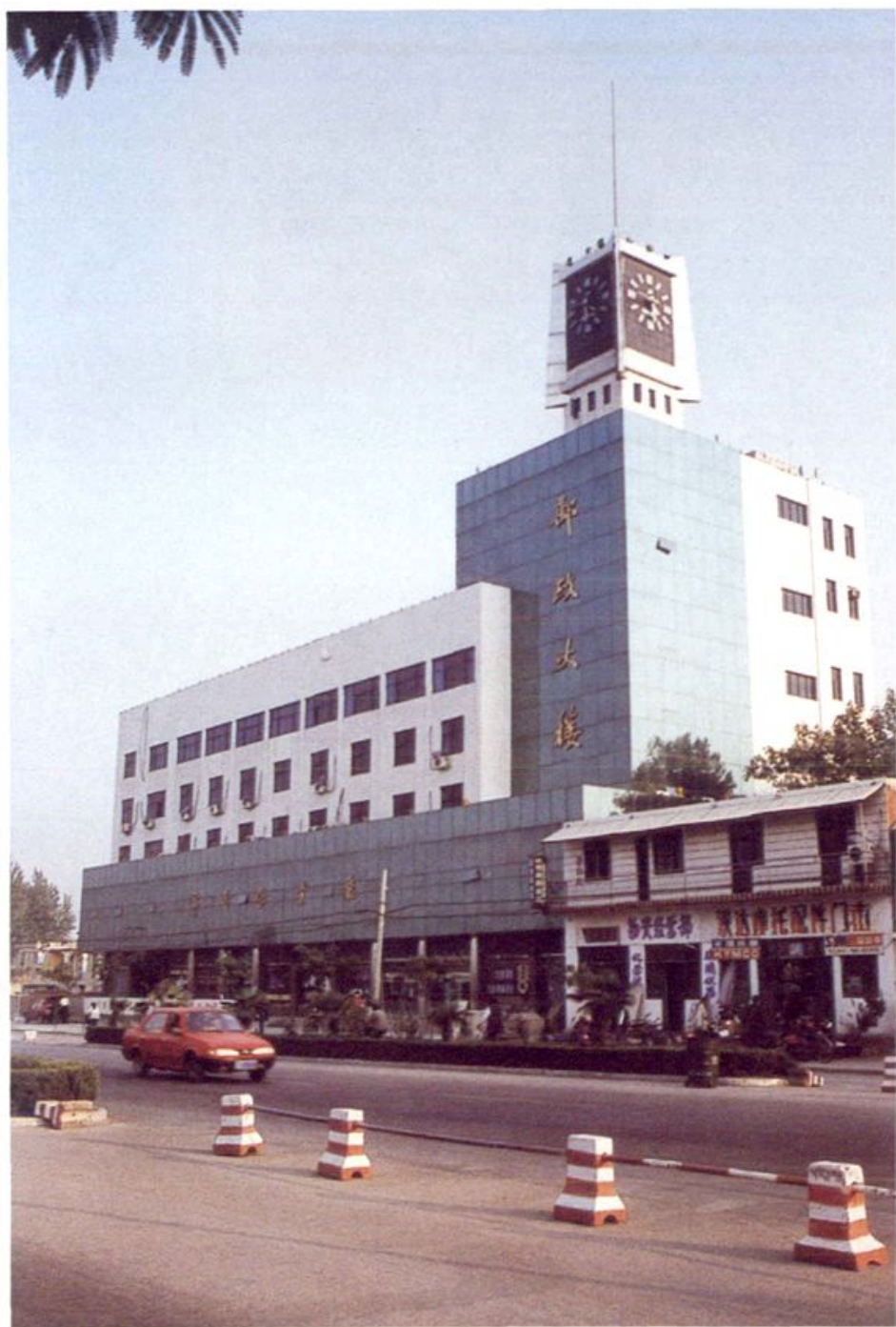
坐落在我府西路的新沂市邮电大楼（1996年建成）
