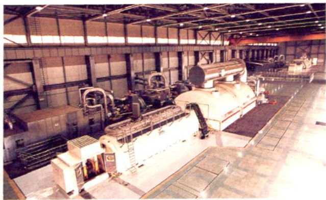
邯峰发电厂2台66万千瓦发电机 汽机房
