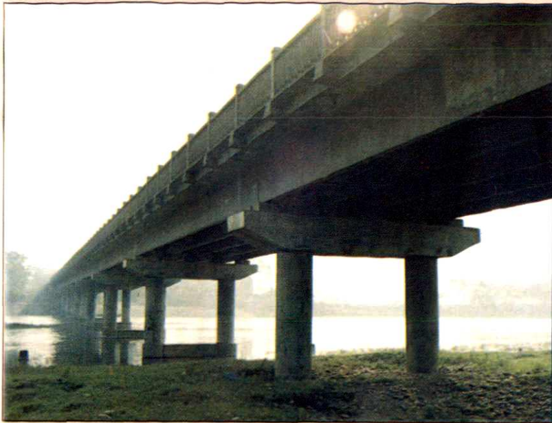
◀成都县道公路上最长的大桥—— 新津龙王渡大桥
