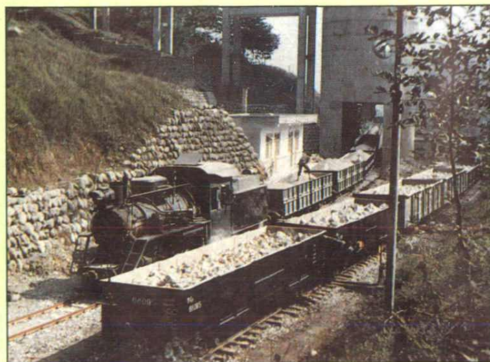
◀列车在彭白铁路清江桥车站装运石灰石
