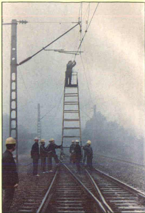
►成都供电段职工维修线路
