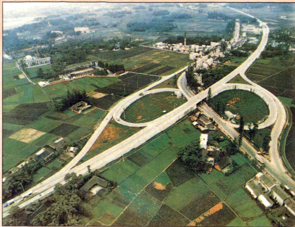
►新津蔡湾立交桥 (川藏公路与大件 路立交)
