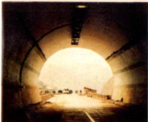
▲建设中的成都高等级公路上的龙泉山隧道
