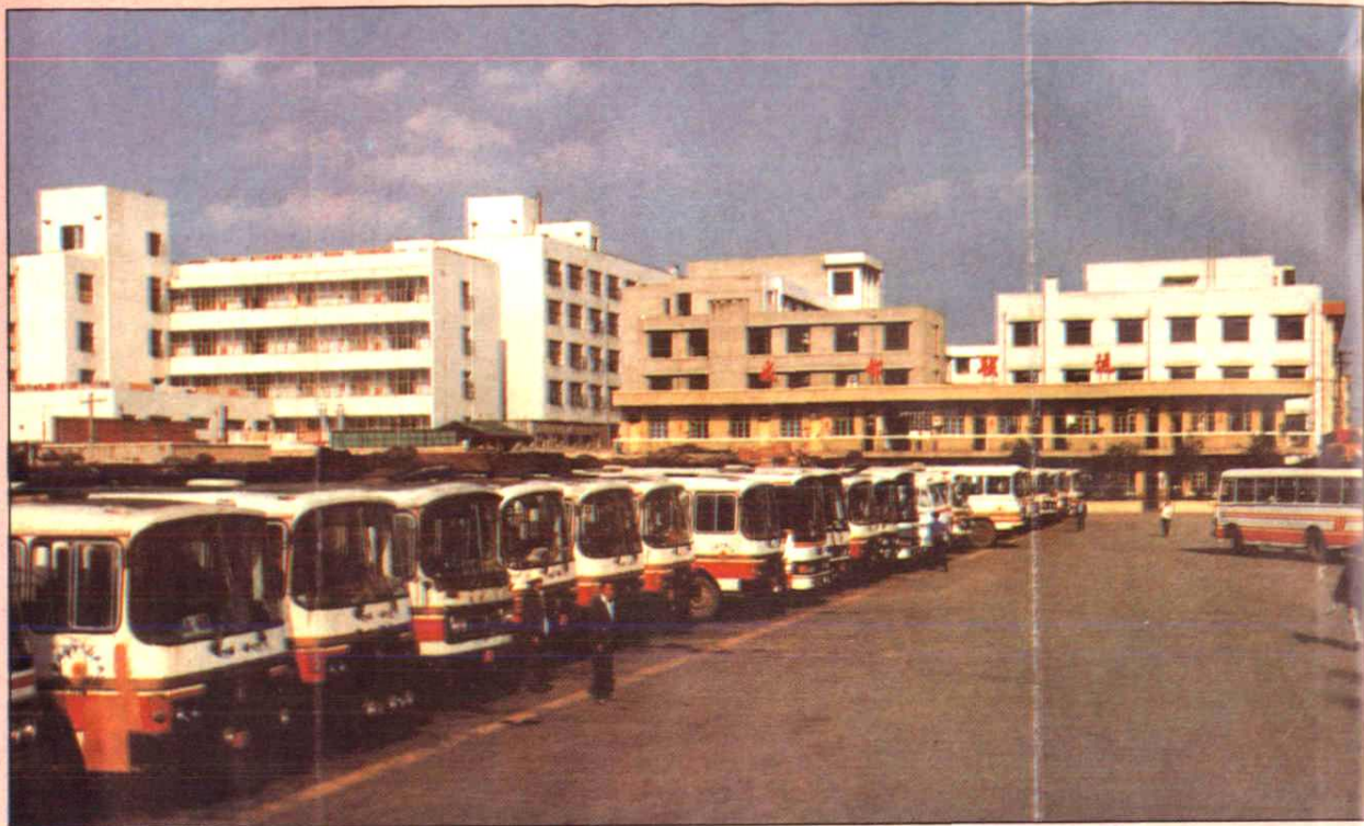
▲成都城北公路客运中心停车场
