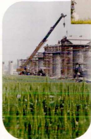
浇注西金厂特大桥墩混凝土。
