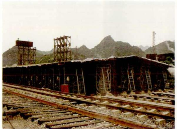
南昆线那厘制梁场新配置的5套预应力钢模工装。
