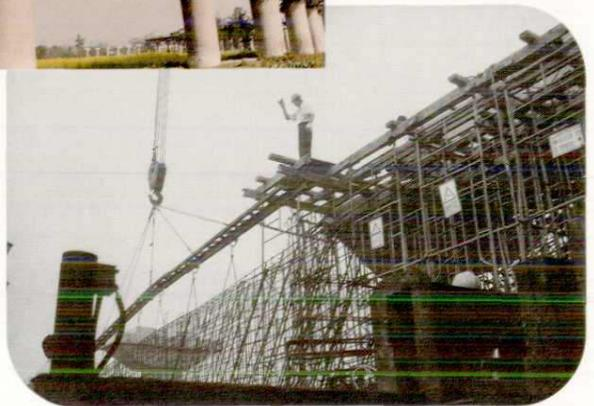
吊安西金厂特大桥现浇梁主筋骨架。
