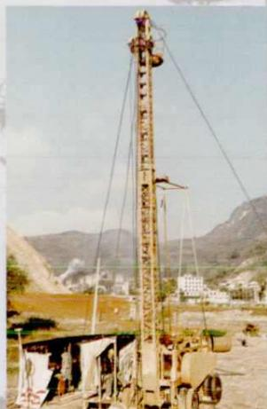
在西康线镇安进站公路桥施工中首次采用S120型钻机钻孔。
