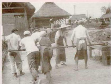
50年代人工弯制普通梁主钢筋工艺。
