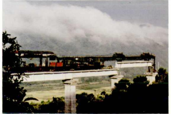
南昆铁路架设公司在那厘制梁场生产的32米预应力梁。
