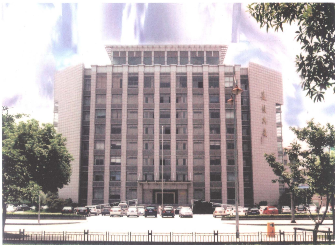
余杭区建设大厦（2009年·临平）
