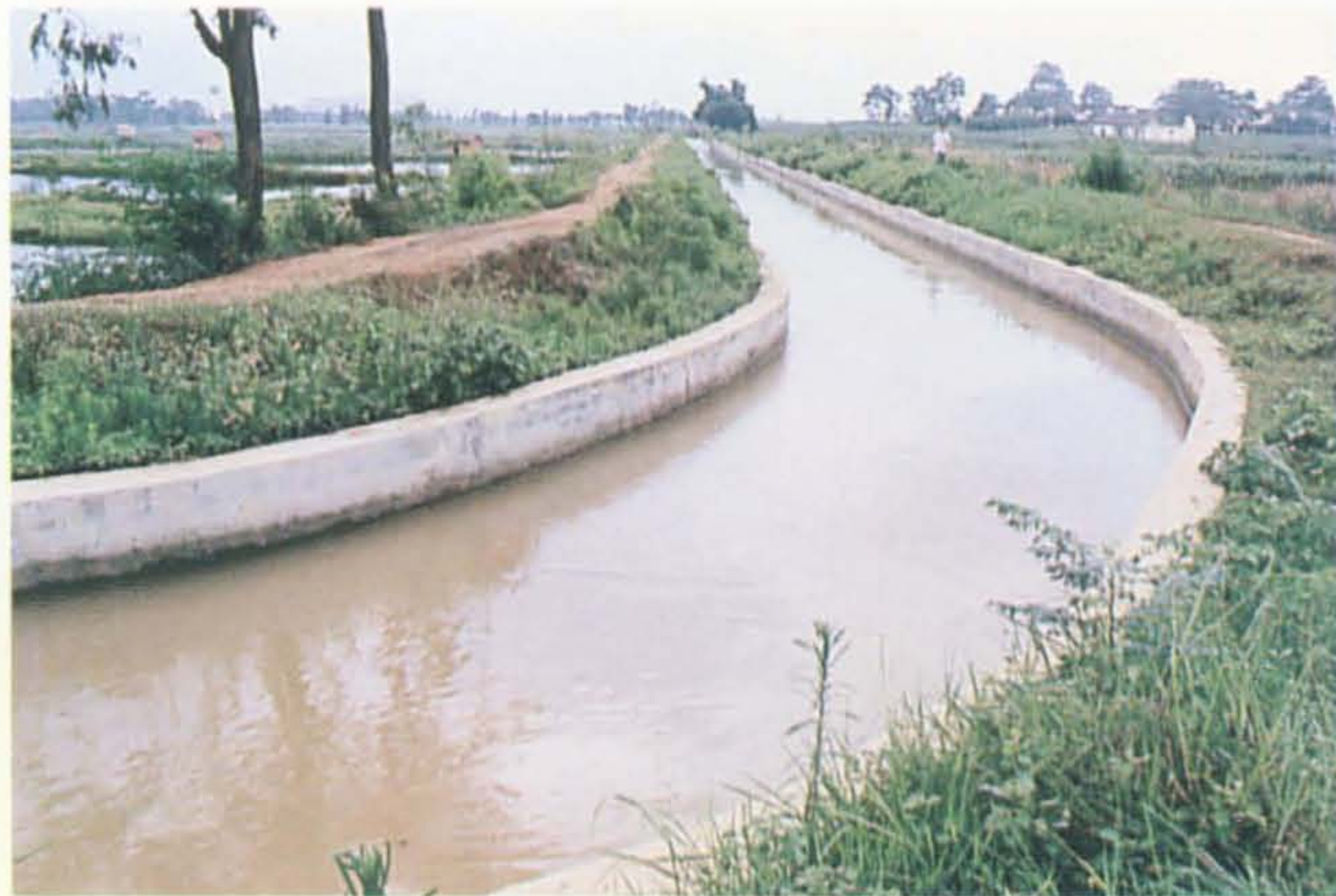
西江拦河引水干渠
