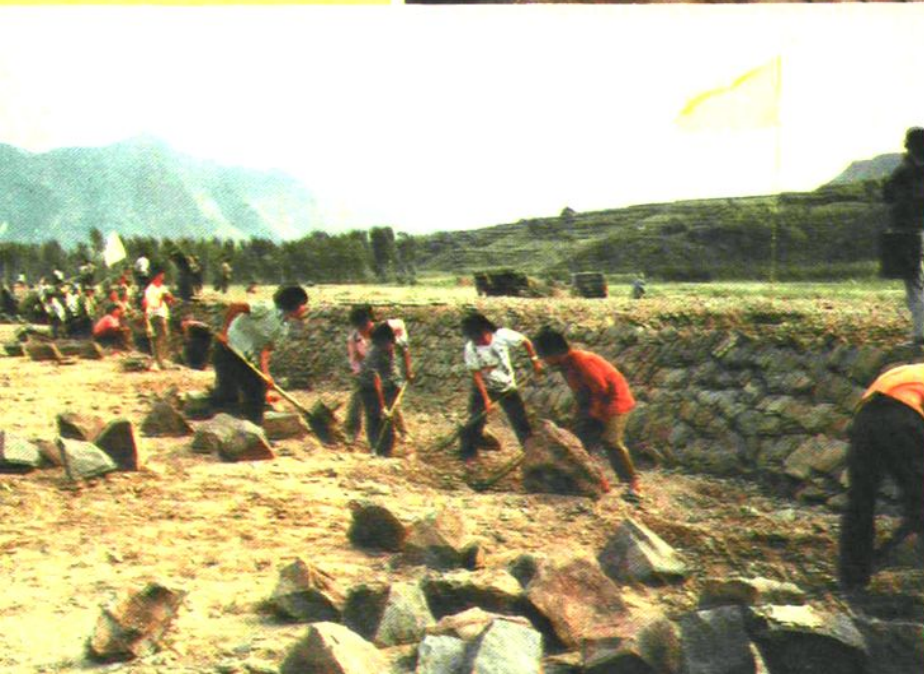
小汤头沟青龙山万米防洪坝施工现场面
