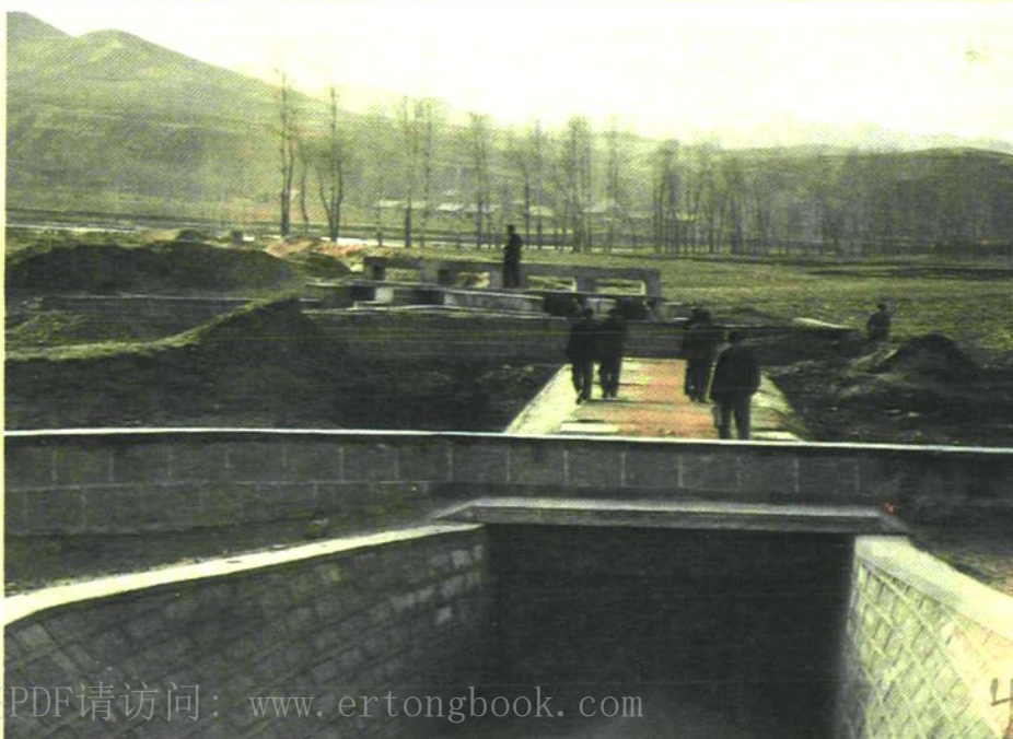
驿玛图河流域兰旗渠渠首闸枢纽工程
