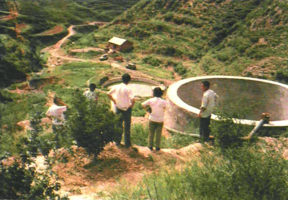
河东金鸡沟三级扬水站
