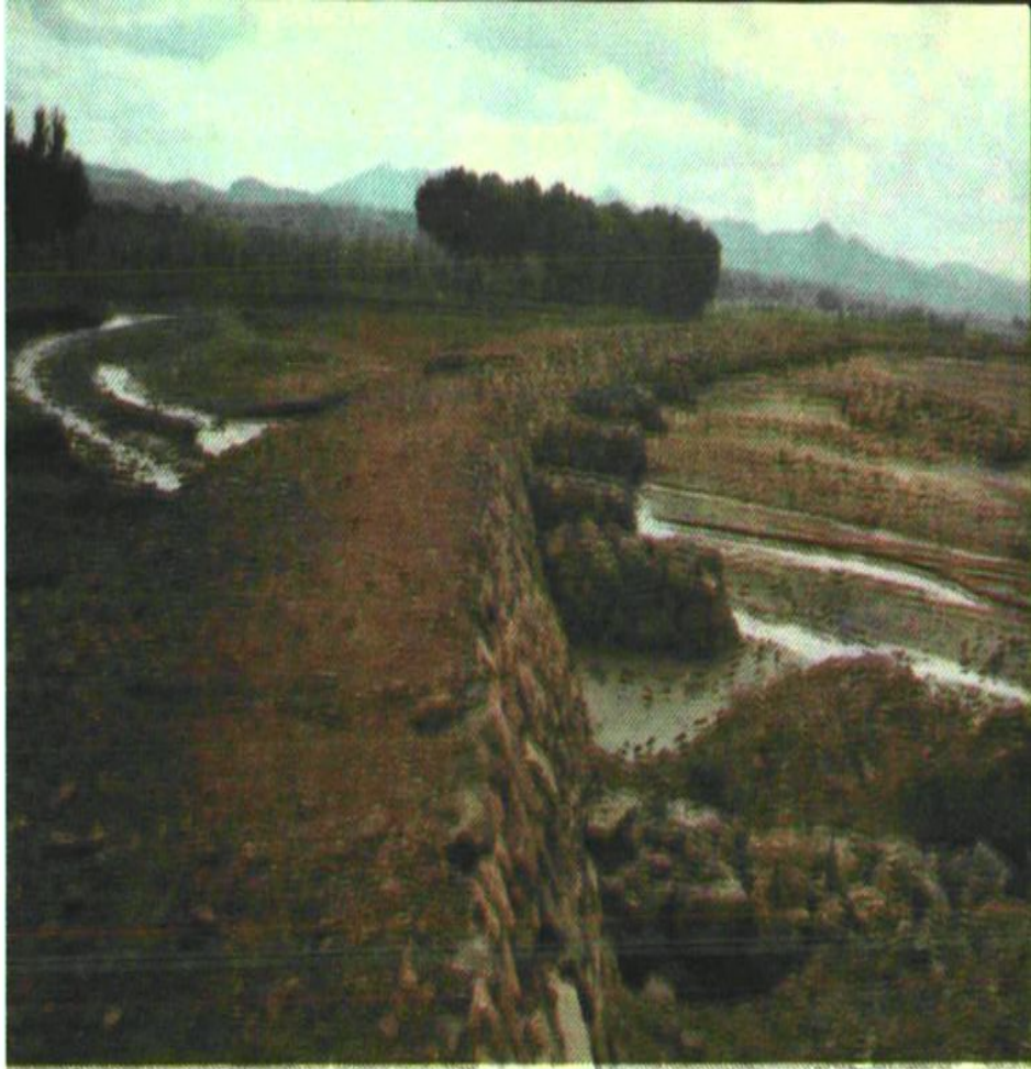
偏坡营村护地坝工程
