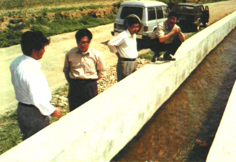
省水利厅领导检查二道湾防渗渠
