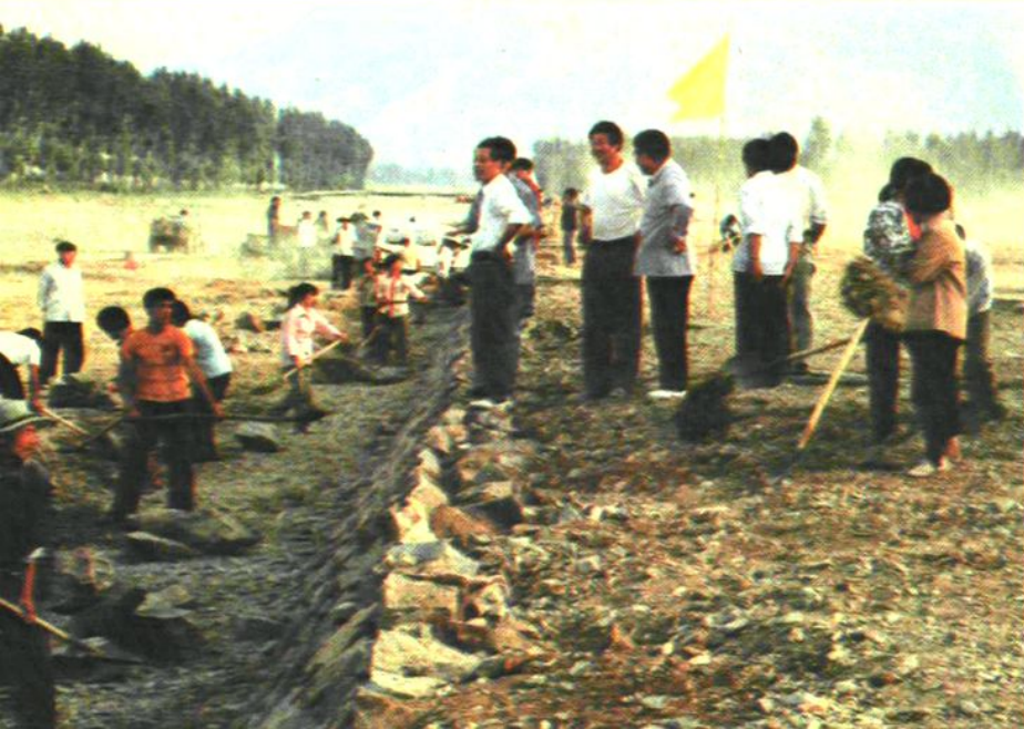
水毁恢复工程 省、市、县领导检查「七·一」
