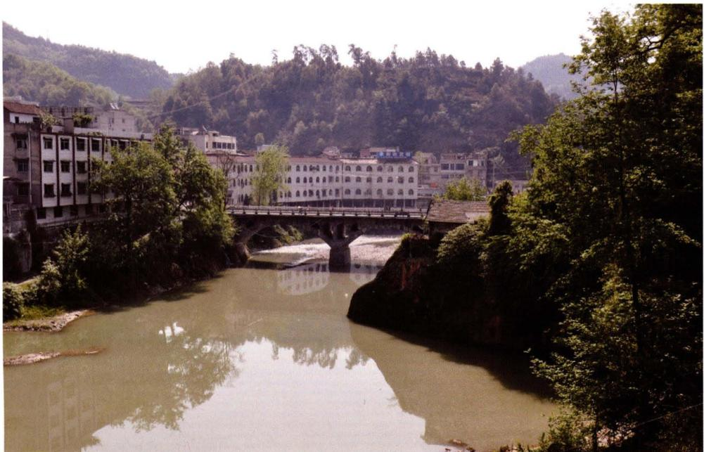
1970年，位于龙凤集镇中心带水河上的龙凤大桥建成，为318国道上的主要桥梁之一，桥长74米，宽7米，可承载重量60吨。图为大桥一角（彭清华摄于2000年）
