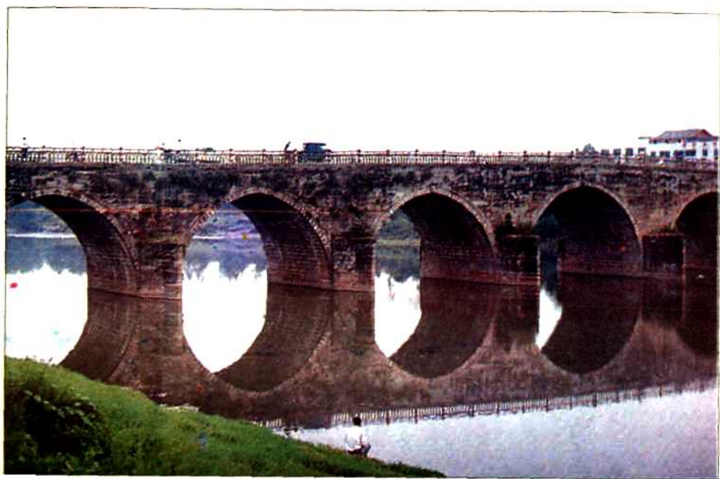
108国道古南桥(建于1836年)
