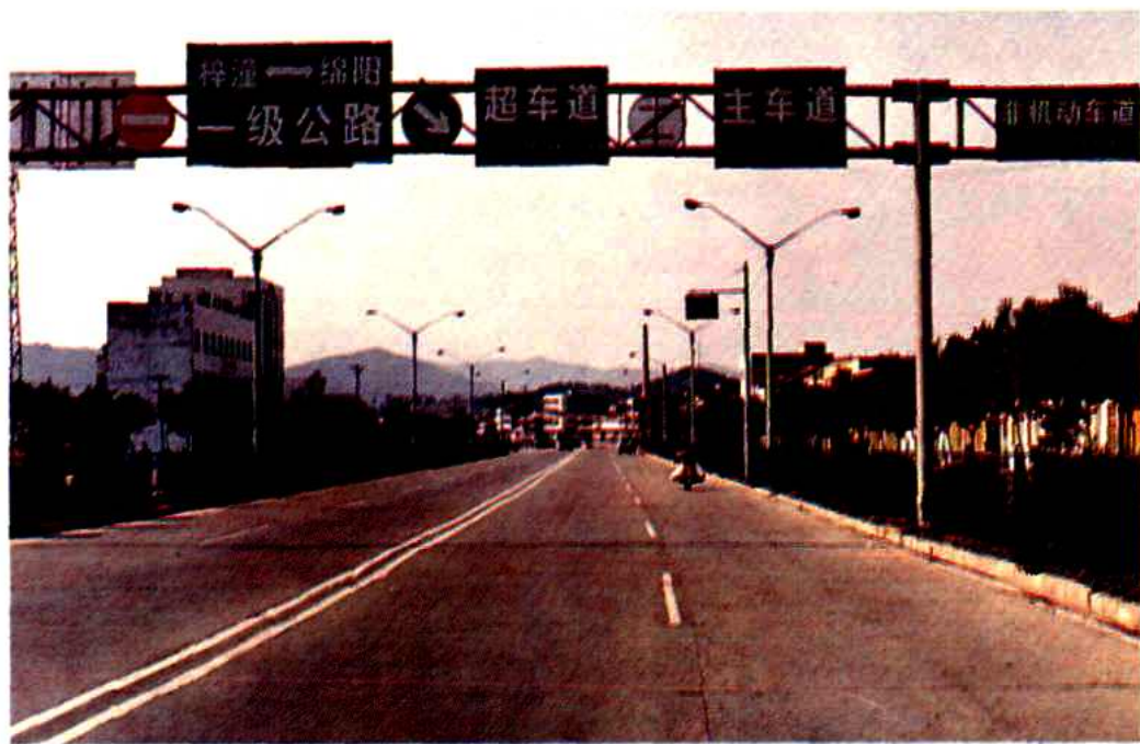
108国道绵梓段一级公路
