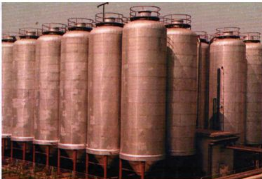
啤酒厂发酵罐
