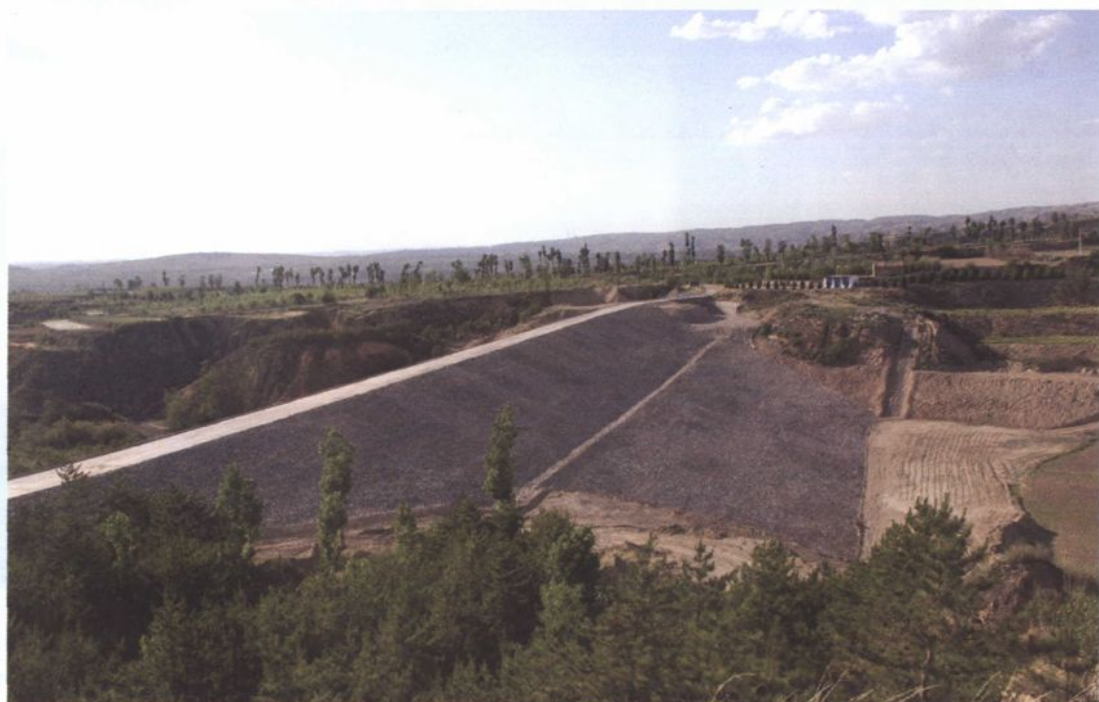
除险加固以后的曲峪水库大坝（杜鹏飞 摄）
