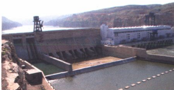
龙口水利枢纽 (龙口水利枢纽管理局提供)
