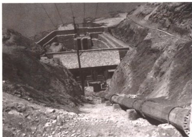
20世纪80年代的大东梁电灌站一级站
