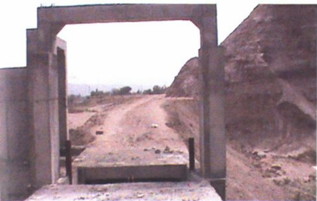
引黄灌溉工程的输水箱涵、启闭闸门 (韩骏飞 摄)
