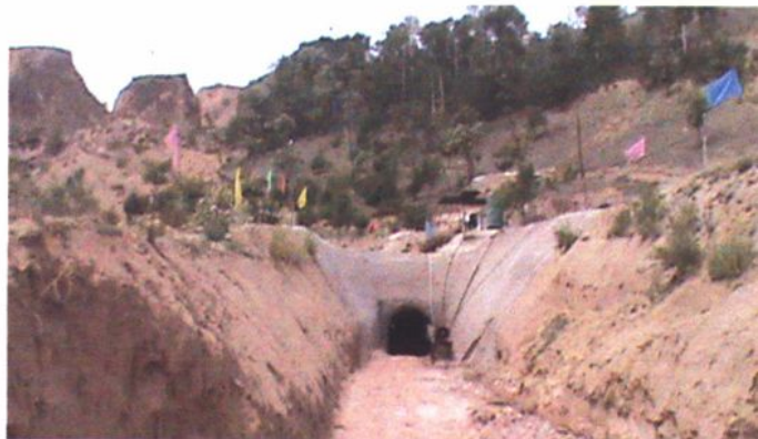
引黄灌溉工程的输水隧道 (韩骏飞 摄)
