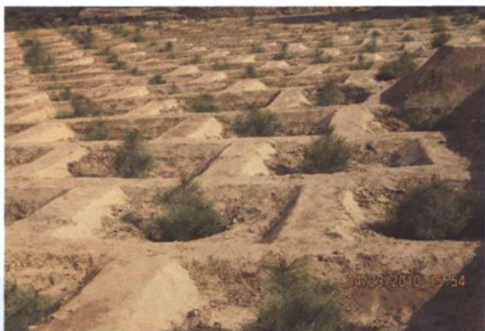
坡面生物治理与回字坑整地工程 (梁建鹏 摄)
