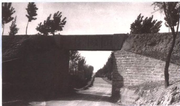
20世纪60年代的大东梁电灌站二级渡槽
