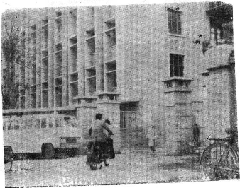
四〇六医院门诊住院大楼。
