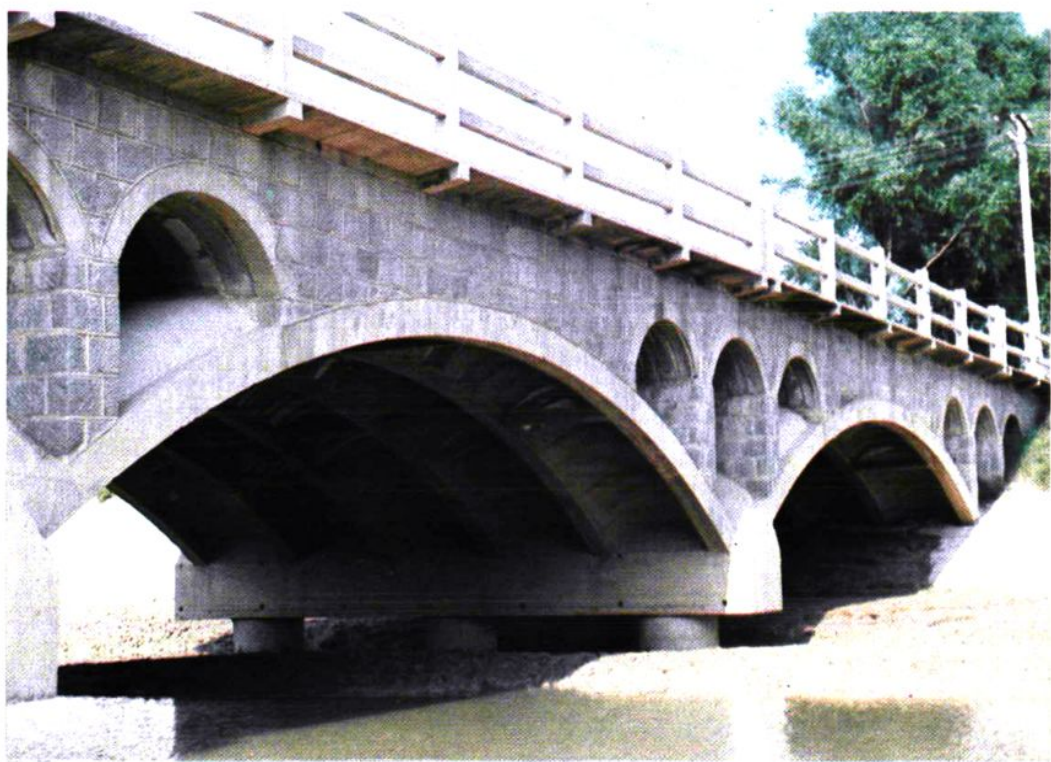
临商河牛王双曲拱桥，四孔，单孔跨十米，全长五十米。建于一九七七年。
