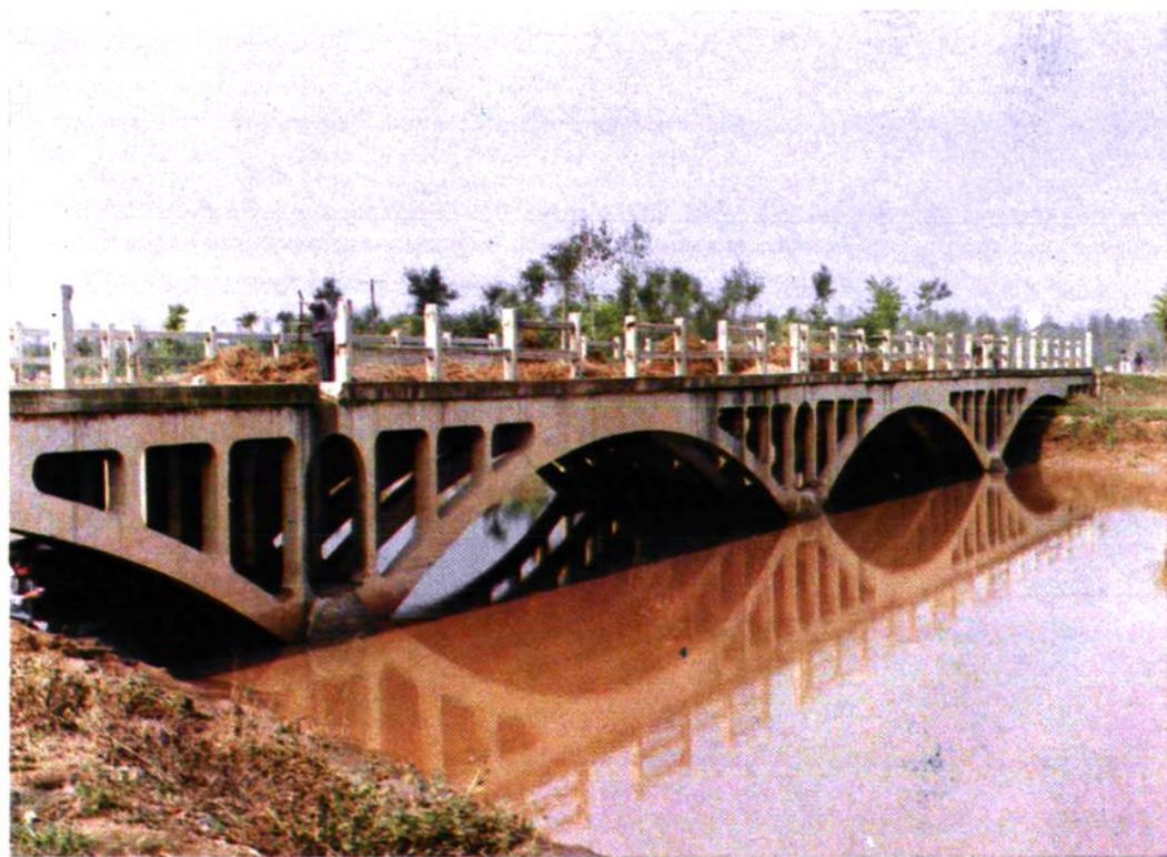
邢家渡总干渠罗屯公路桥，拱桁架结构，墩台基础，四孔跨径十三米，全长四十二米，建于一九七四年。
