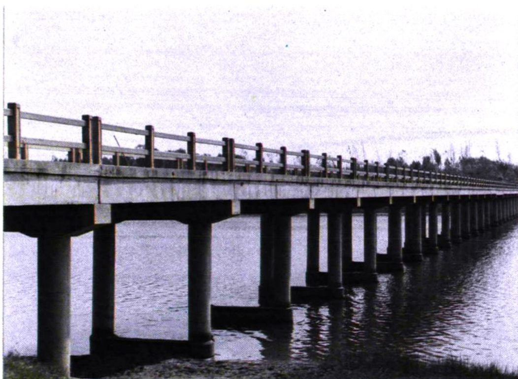
靳家道口桥 \pi 型梁结构，双柱式桥墩灌注桩基础。二十九孔，主孔跨径十米，其他孔跨六点六米，全长一百九十五点四米，建于一九七九年。
