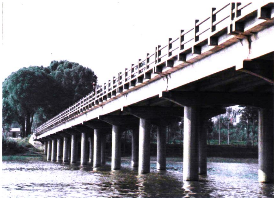
垛石公路桥T型梁，微弯板结构，双柱式桥墩灌注桩基础。全长一百九十七点四米，建于一九六九年夏。
