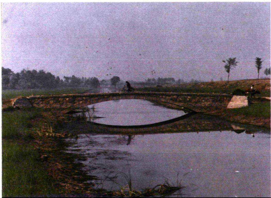
土马河郑家石拱桥，一孔，孔跨二十米，全长二十五米，建于一九七二年四月。
