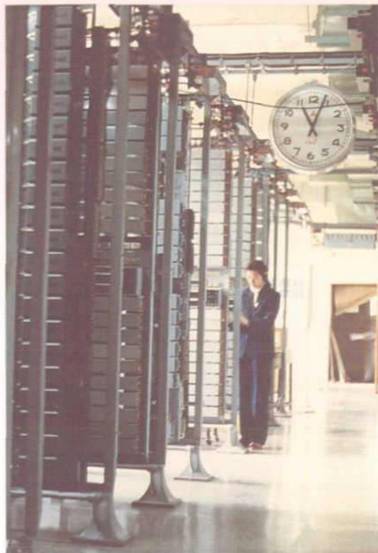
1956年郑州市首先安装步进制市内电话交换机，打破河南无市内自动电话的历史
