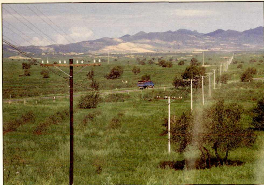
1993年10月建成的赤峰—通辽光缆线路
