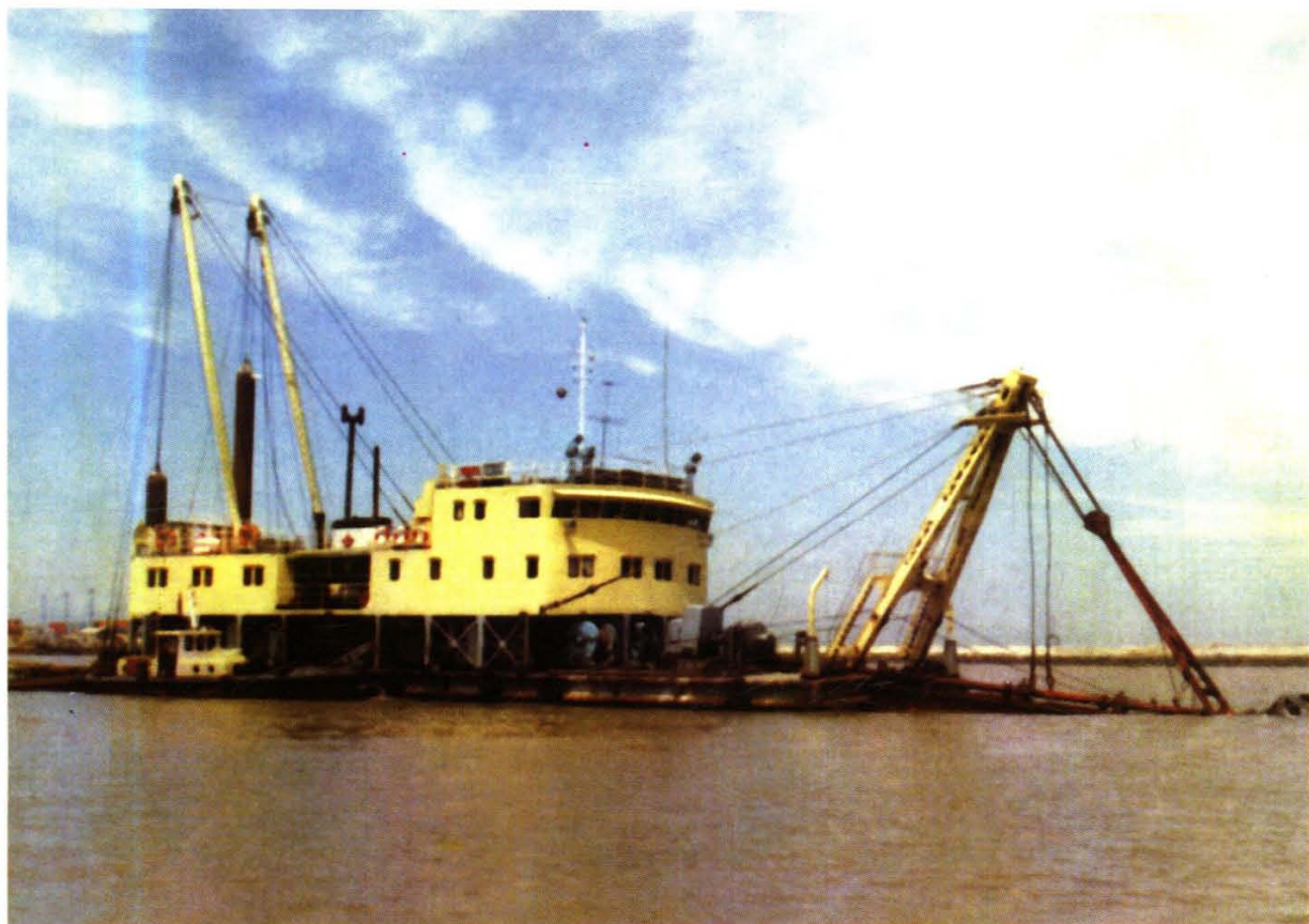
350m 3 /h 绞吸挖泥船 —— “津航浚 201”
