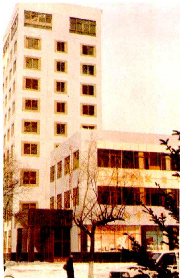
机电设备公司地址 长安路 303 号
