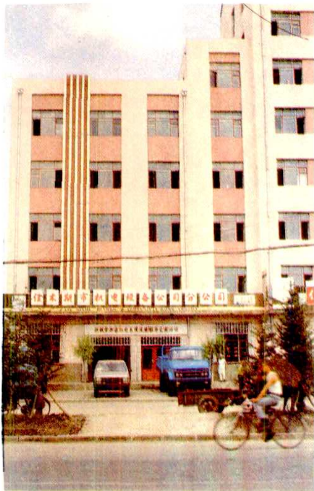
机电设备公司第一供应站
