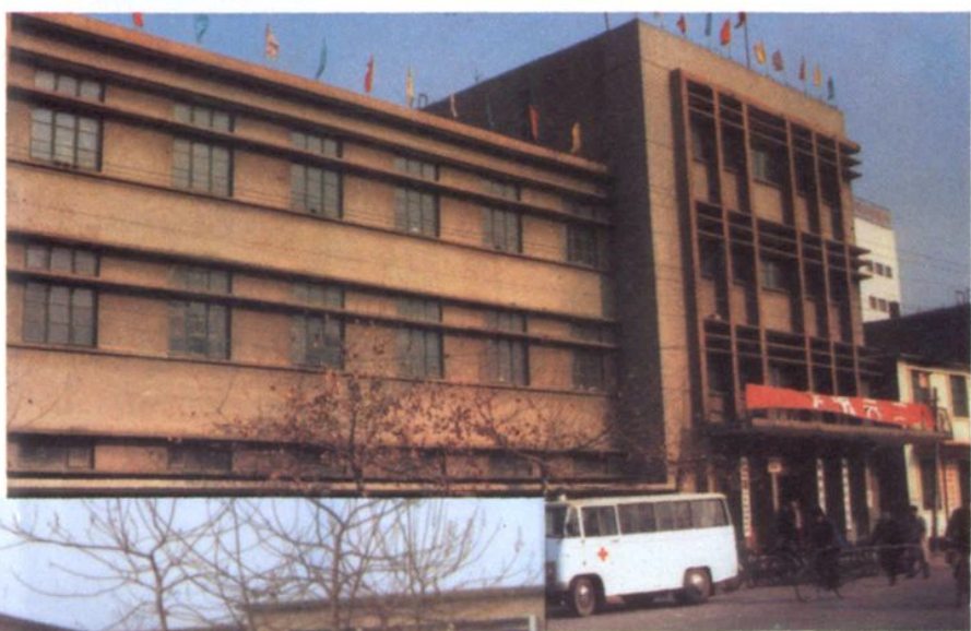
▶ 滕县卫生局1987年迁入府前中路办公楼。
