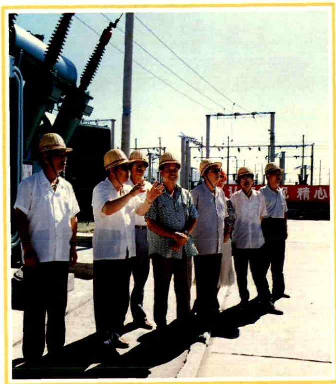
晋城供电公司党政领导在高平 110 千伏变电站视察工作,左起:孙仪、胡家群、阎成明、徐良毅、宋晚和、邱杨、刘予胜、牛春锁
