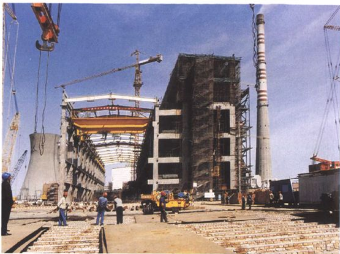
▲ 二期工程主厂房建设
