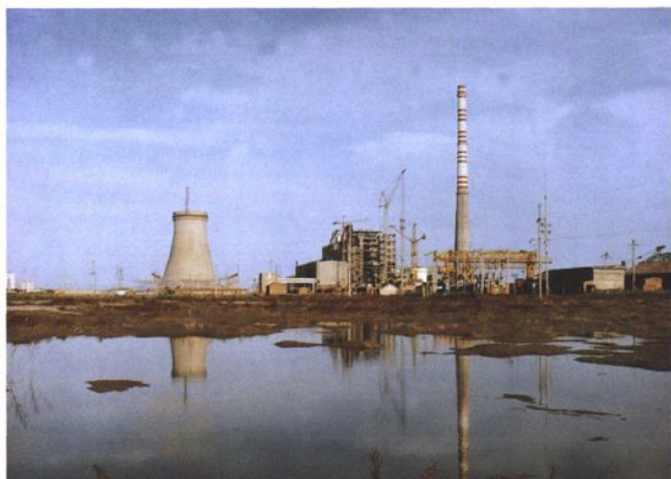
▲ 电厂一期工程建设工地
