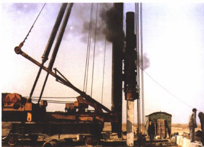
▲ 1988年9月13日，电厂一期工程打下第一根工程桩
