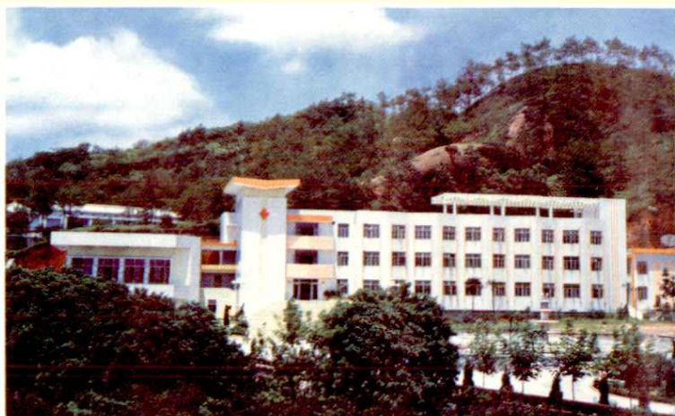
◀ 峨眉疗养院医疗楼
