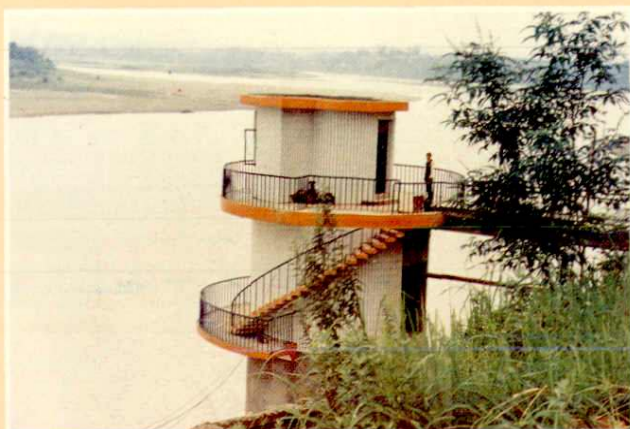
▲ 建于青江畔的疗养院取水装置
