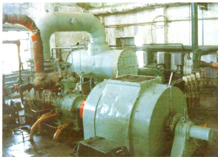
1500千瓦/时窑尾余热发电机组 ▶
