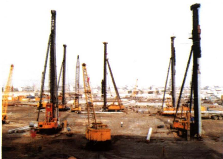
温州发电厂二期( 2 \times 30 万千瓦)扩建工程施工现场
