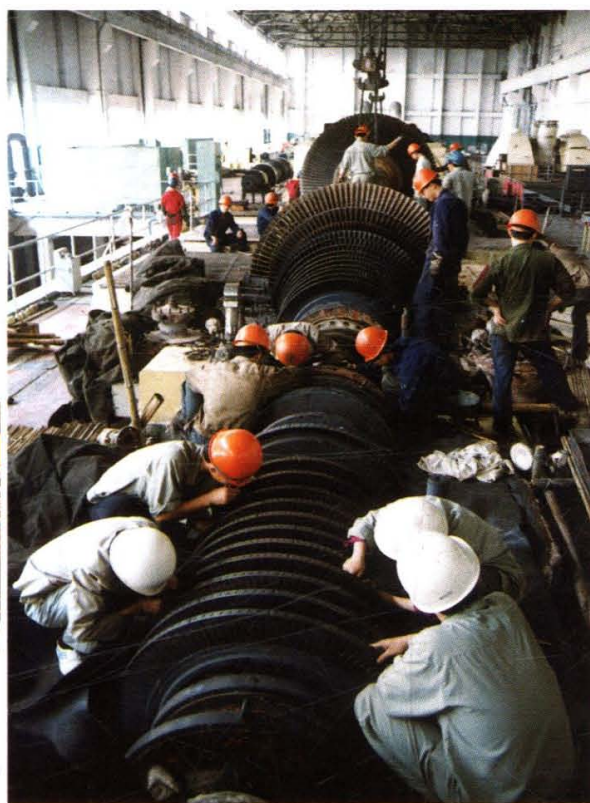
镇海发电厂工人正在检修汽轮 机组
