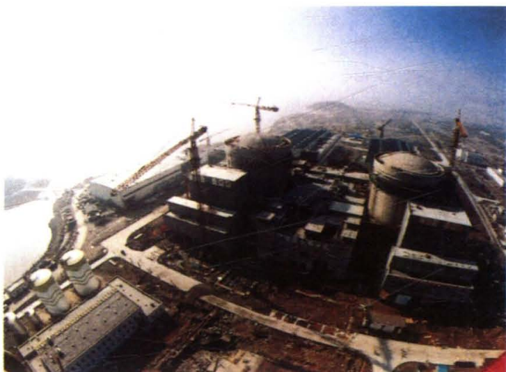
建设中的秦山核电厂二期工程( 2 \times 60 万千瓦)
