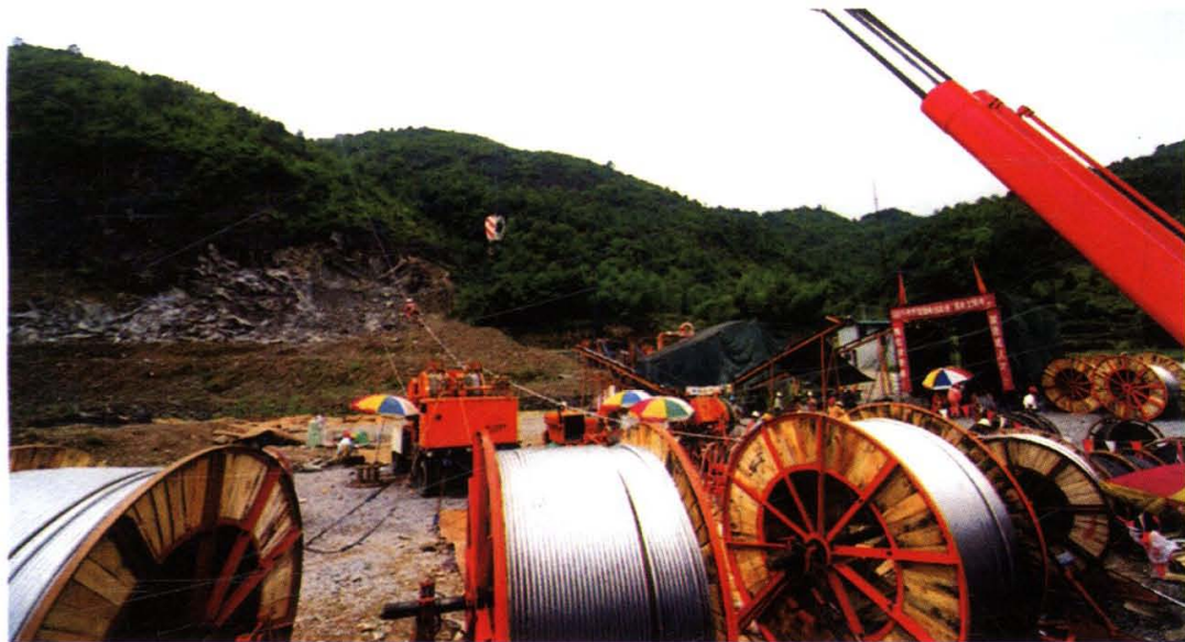
紧张施工中的 500 千伏输电线路
