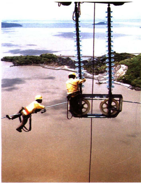
电力职工在舟山一岱山 110 千伏跨海联网工程作业
