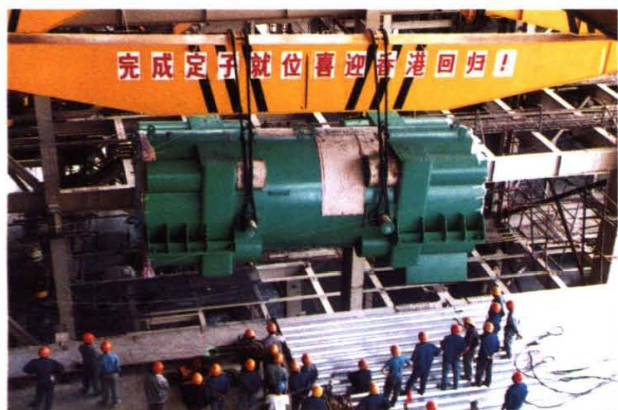
1997年6月19日，北仑发电厂二期 工程3号发电机定子吊装就位
