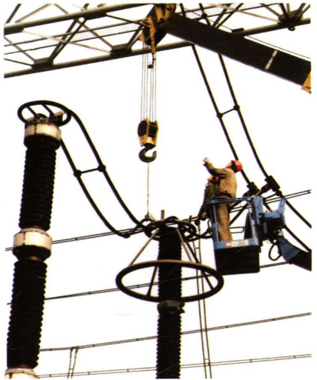
500 千伏瓶窑变电所 3 号主变压器扩建安装户外构架
