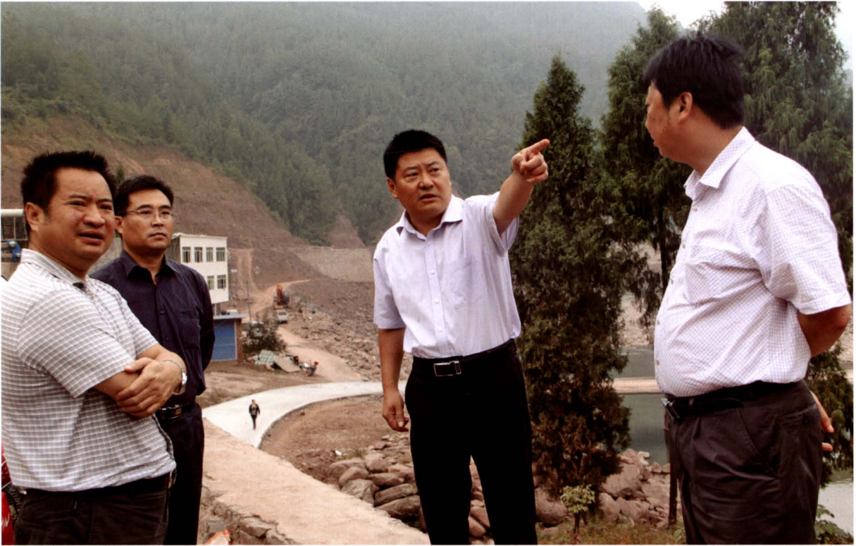
现任县委副书记、县长李善君（右二）在绕城路灾后重建工地检查指导工作
