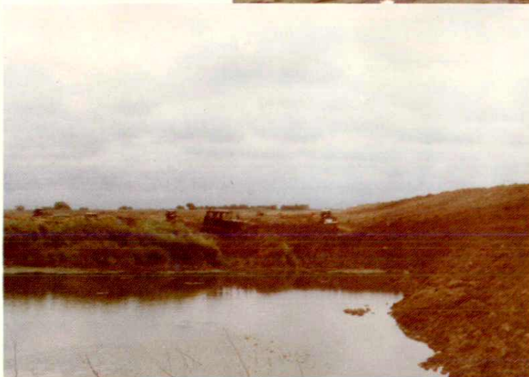
◀ 修筑防洪大堤
