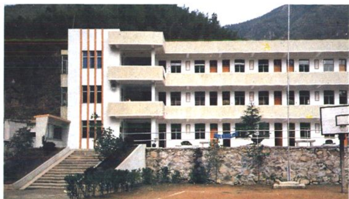
革命老区山区村校横街镇半山小学教学楼
