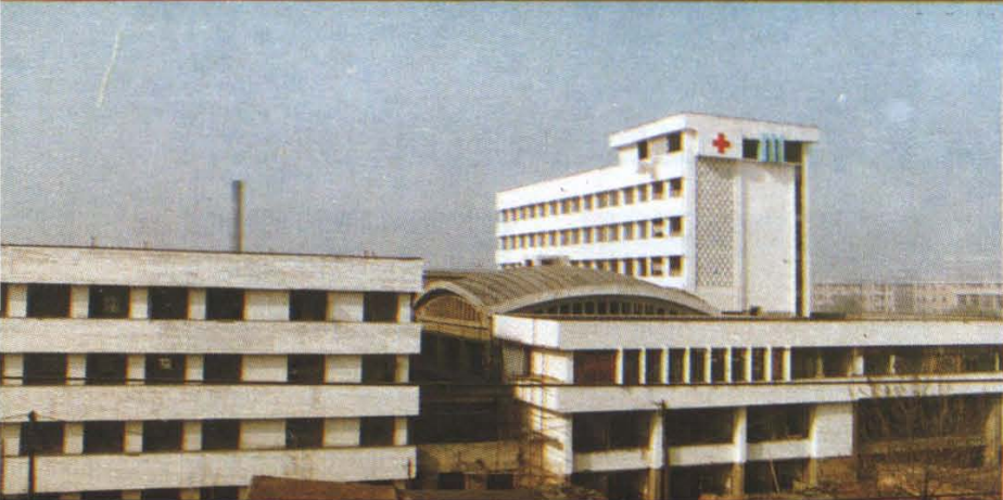
即将竣工的第一附属医院 新门诊大楼
