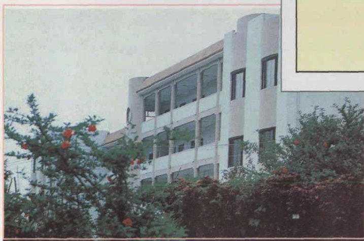
▲ 公平中学教学大楼
