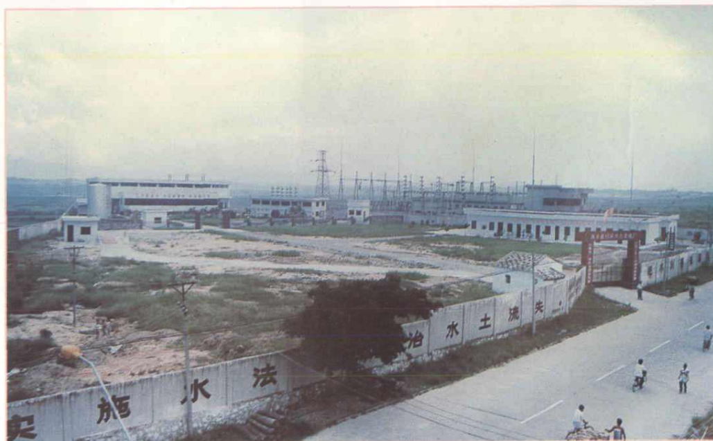
▲ 公平日兴火力发电站
