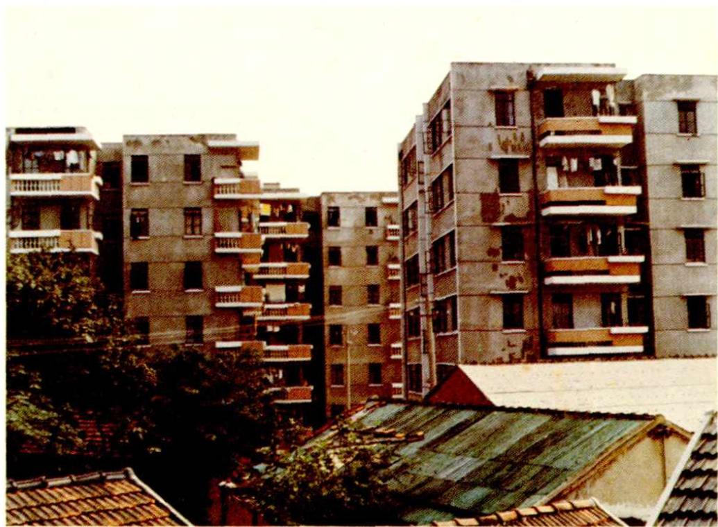
1976年建成的工厂家属区一角
