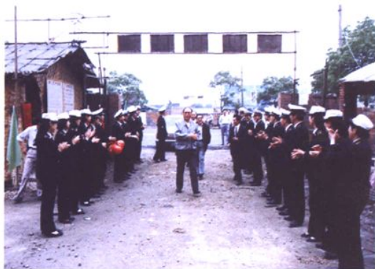
1991年3月海关总署署长戴杰视察苏州海关大楼建筑工地
