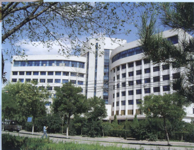
国电靖远发电公司科技楼
