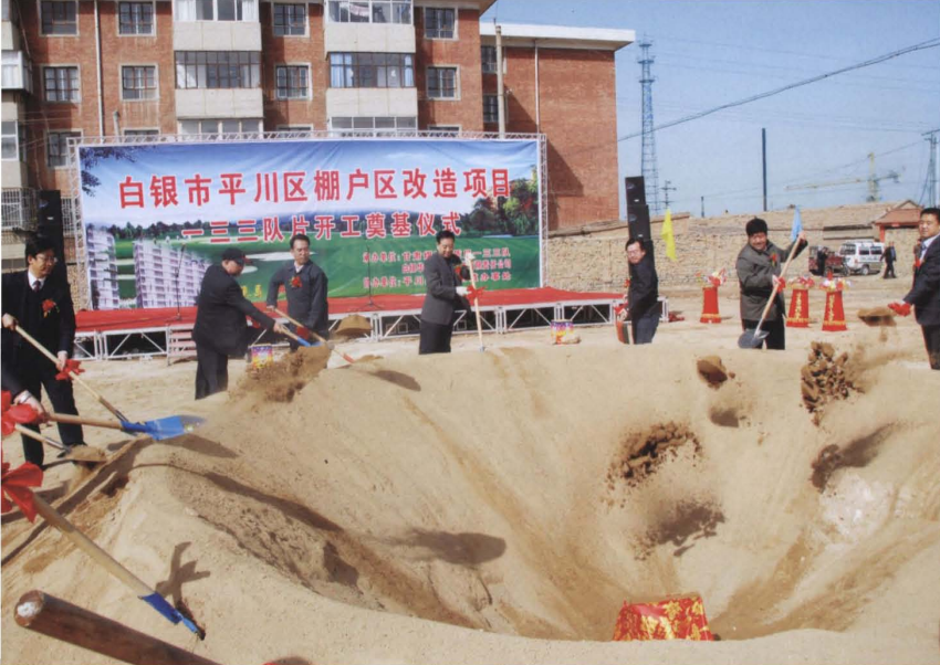
2010年3月16日，平川区棚户区改造项目一三三队片区开工建设
