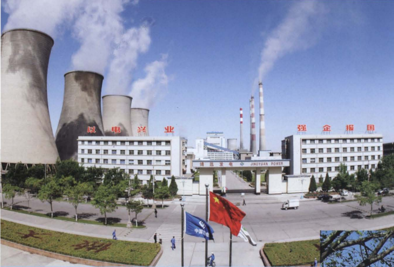
西北地区最大的火力发电厂——国电靖远发电公司
