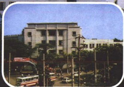
始建于1956年的郑州二七路电信综合通信大楼，是五十、六十、七十年代河南最大的电信大楼
