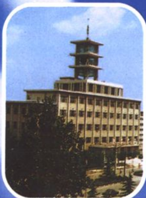
1982年建成的郑州长途电信枢纽楼是当时全国最大的电信枢纽楼之一
