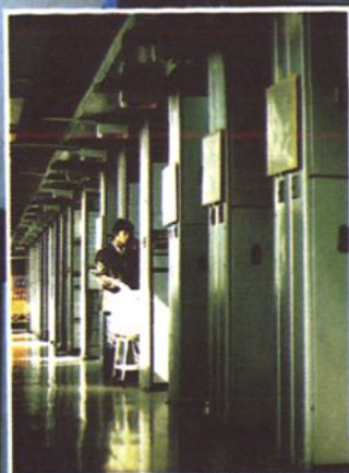
80年代郑州电信局长途 交换1800路载波机房
