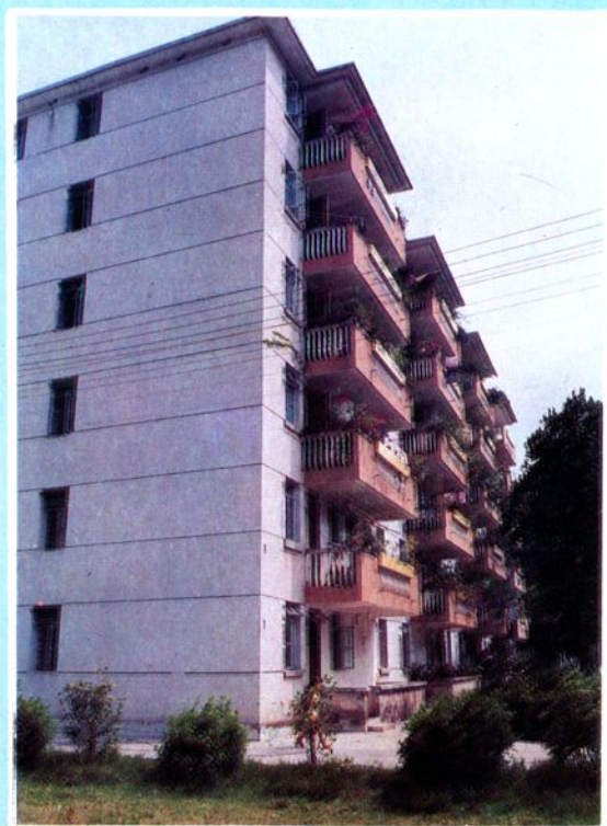
↑ 新建站、所宿舍楼 (1988)
