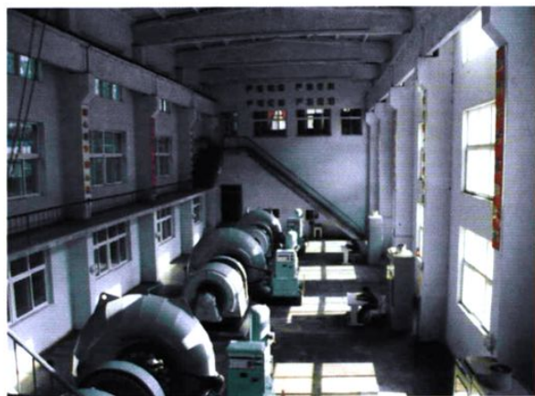
马路湾电站厂房
