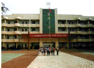
县第一高级中学教学楼
