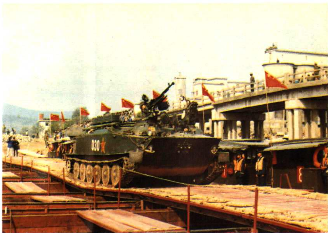
60 吨战备钢驳浮桥实载试验成功
