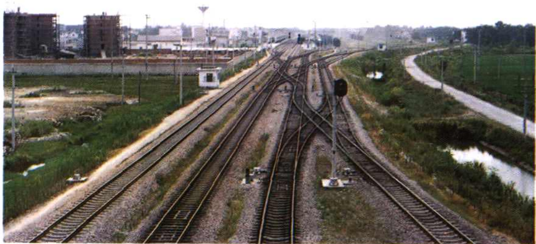
建设中的宣杭铁路与杭甬铁路在长兴接轨
