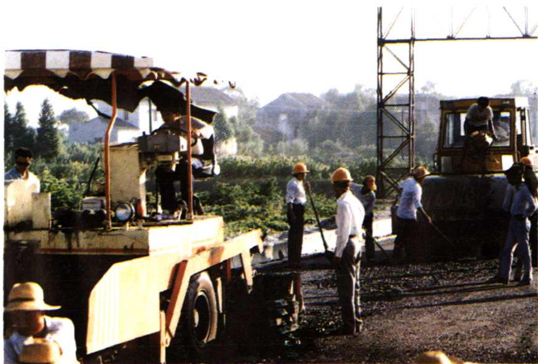
养路工人正在修筑沥青路面
