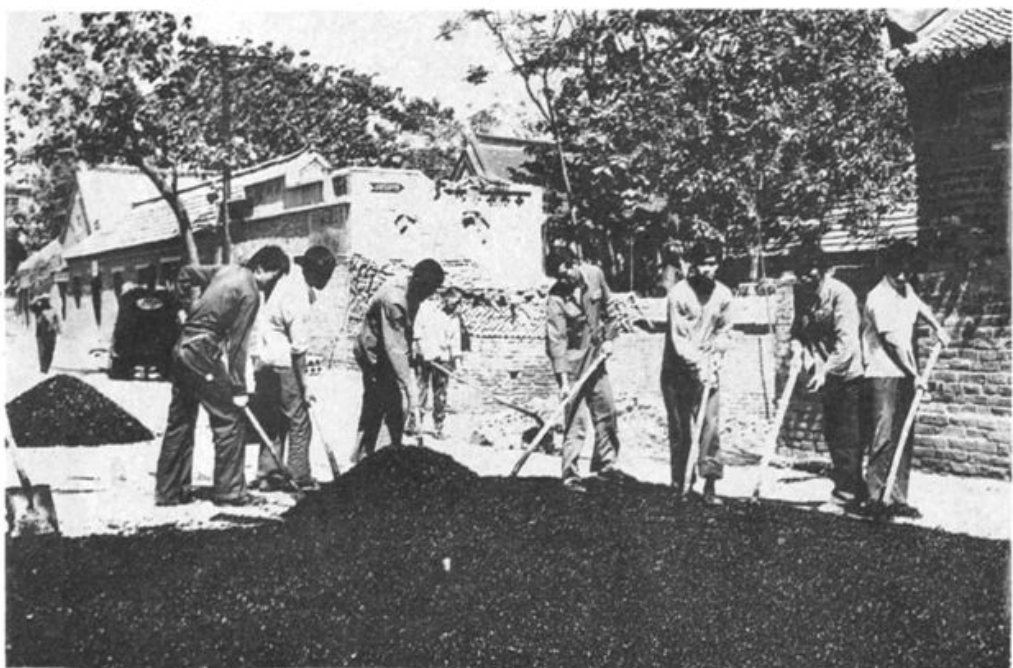
▼ 修路职工精心摊铺乡道沥青公路。
