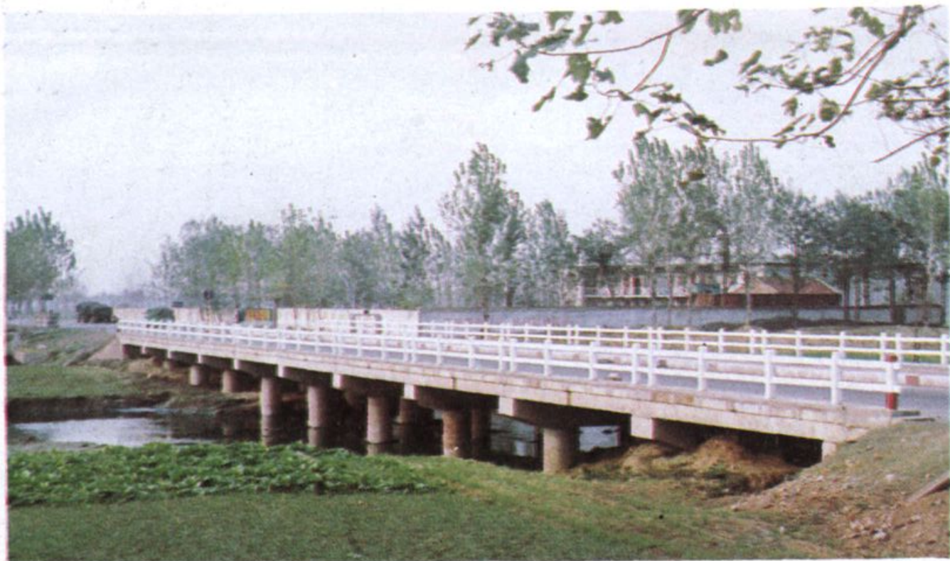
▲ 始修于一九六五年的国道郑开公路堤刘桥。一九八九年三月至九月，对该桥进行了等倍加宽
