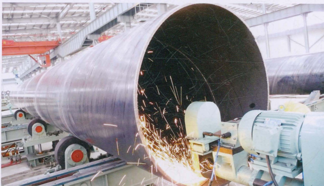
2009年3月，江苏通宇钢管集团生产的螺旋缝埋弧焊管，成功用于中亚天然气管道项目
