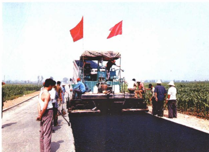
县乡公路 机械铺油
