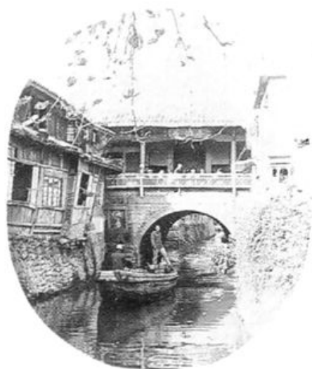
瑞安市区东安碇桥
