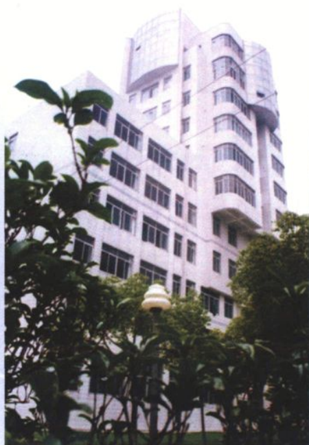
1998年建成的教学综合楼
