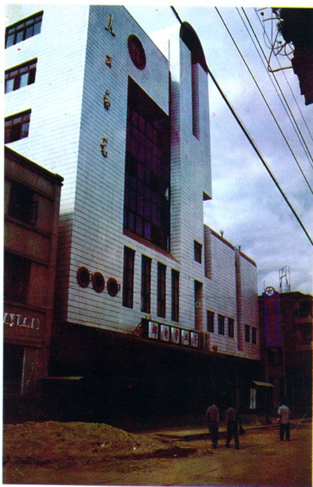
上图：1994年1月竣工的红河县邮电大楼。
