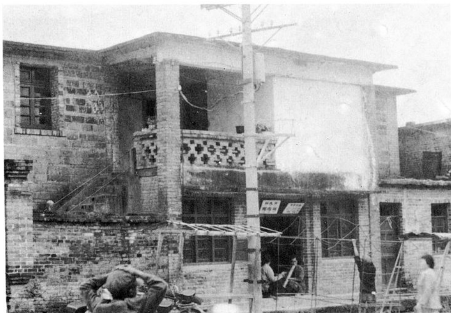
阿扎河邮电所, 1975 年建砖木结构 160 平方米
