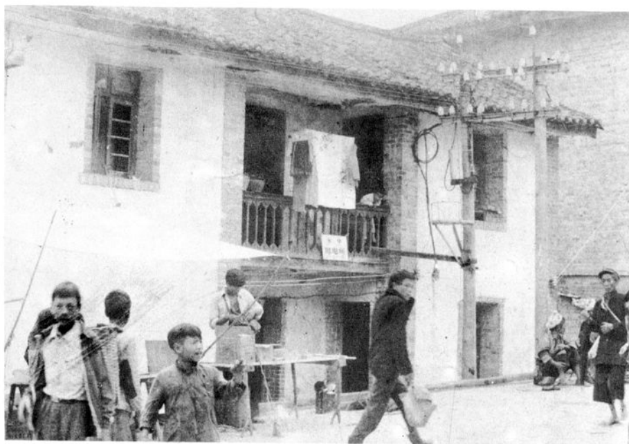
宝华邮电所, 1970 年建土木结构 240 平方米(两幢)
