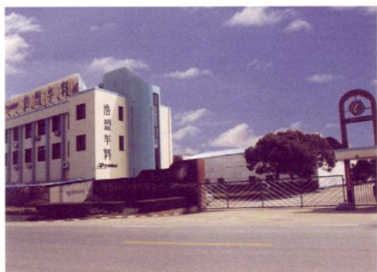
2000年，建于川南奉公路8553号的浩盟车料（上海）有限公司（港商独资企业）
