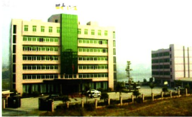
县财政局办公大楼（2000年摄）
