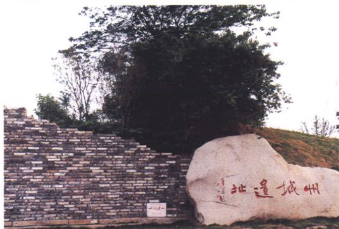
泰州宋代州城遗址及城墙内下水道
