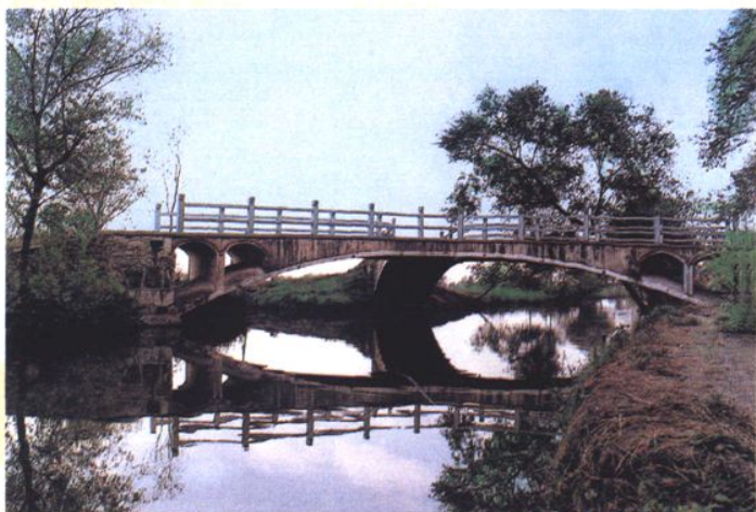
无锡县前洲三叉桥
