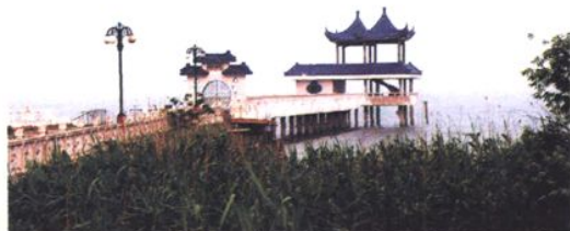
无锡某单位自备水厂取水设施
