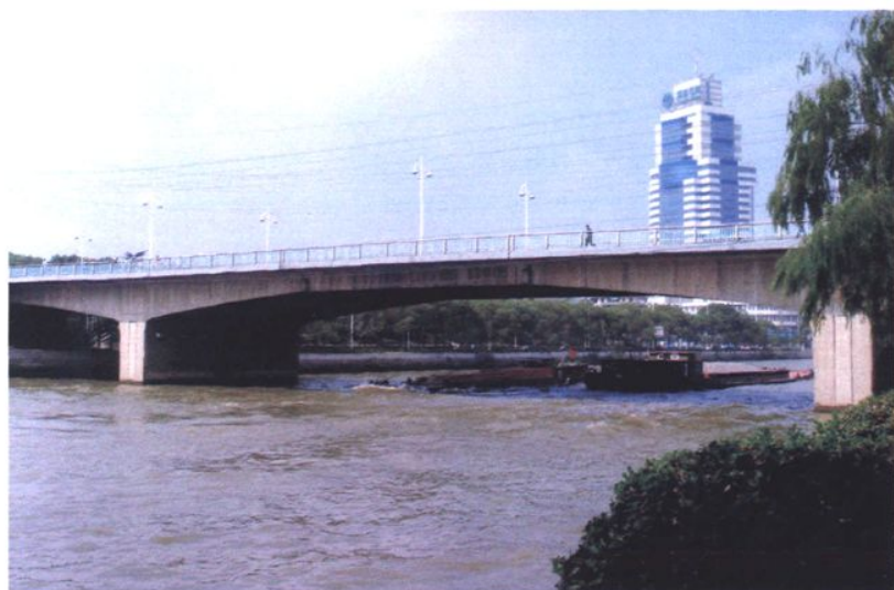
无锡梁溪大桥
