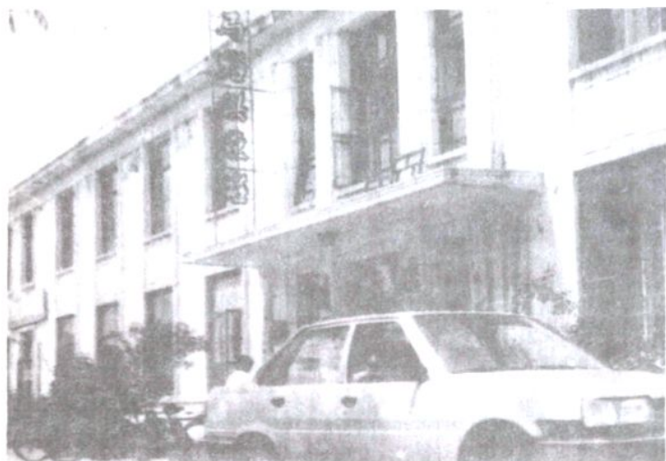
18、 机电公司新马路供应站。(原齐市物资局办公楼)
