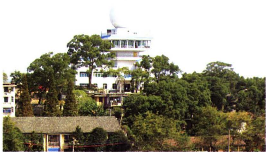
永州多普勒天气雷达站
